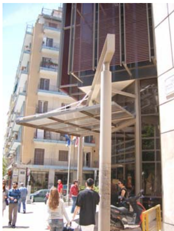
Εικόνα 3 Είσοδος κτιρίου-νοτιοδυτική όψη
