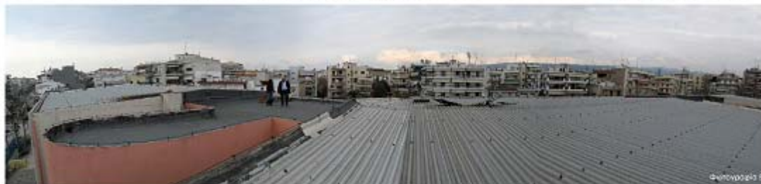
Απόψεις του δώματος και των γειτονικών κτιρίων
