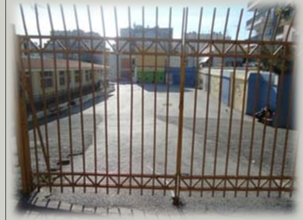
Έλλειψη πρασίνου στο χώρο του σχολείου
