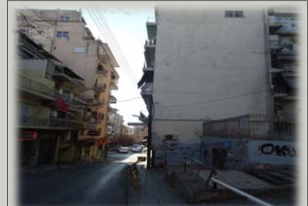
Έλλειψη ελεύθερων χώρων (στενοί δρόμοι) με αποτέλεσμα την έλλειψη πρασίνου
