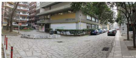
Εξωτερικές Απόψεις του Κτιρίου
