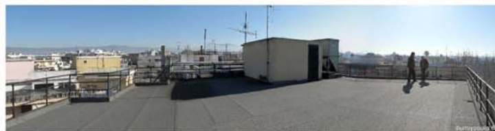
Απόψεις του δώματος και των γειτονικών κτιρίων
