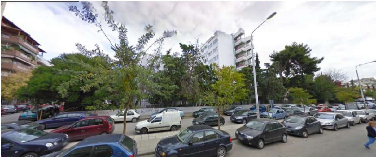
Εικόνα 10: SERVICE ROAD ΜΕΤΑΞΥ ΚΡΙΤΩΝΟΣ & ΕΙΣΟΔΟΥ
