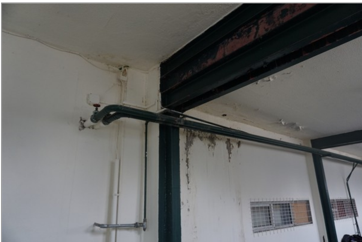
Εικόνα 8: Μεταλλικό πλαίσιο και εμφάνιση υγρασίας σε προκατασκευασμένο πάνελ
