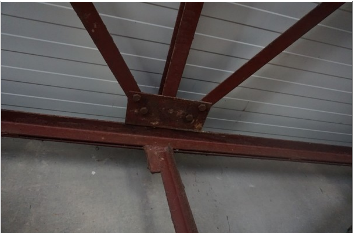
Εικόνα 6: Έναρξη οξείδωσης συνδέσεων
