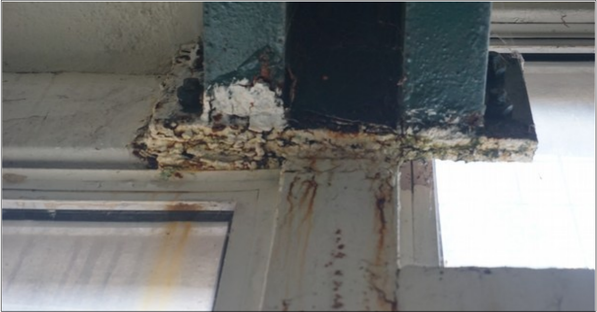
Εικόνα 5: Οξείδωση ελασμάτων και διατομών δοκού και στύλου
