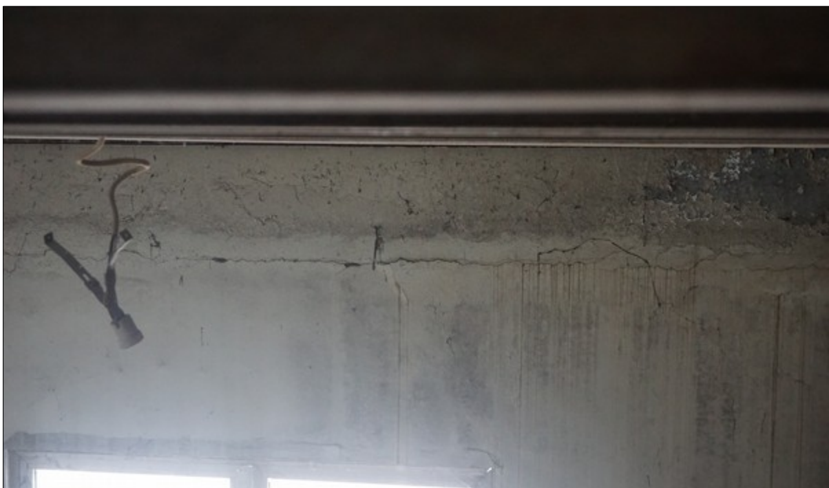
Εικόνα 10: Διείσδυση υγρασίας κάτω από τη στέγη
