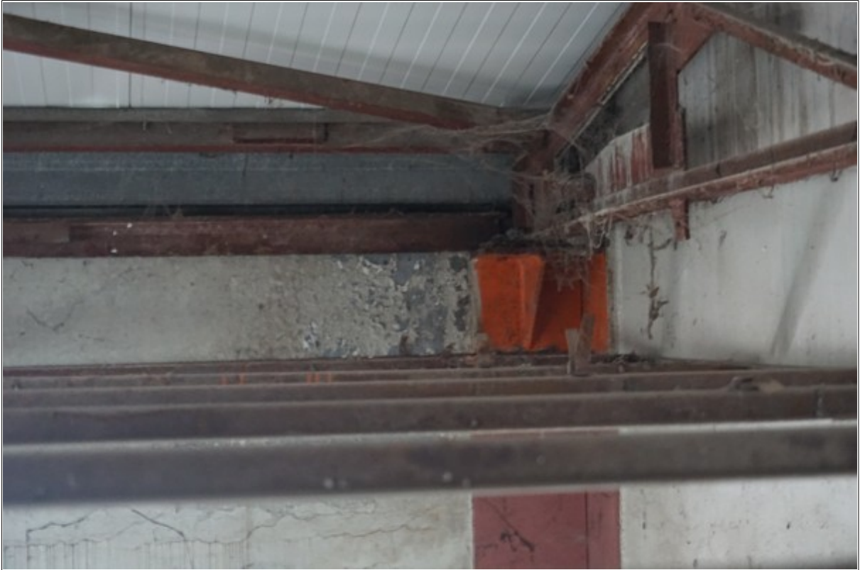
Εικόνα 7: Οξείδωση μεταλλικών στοιχείων
