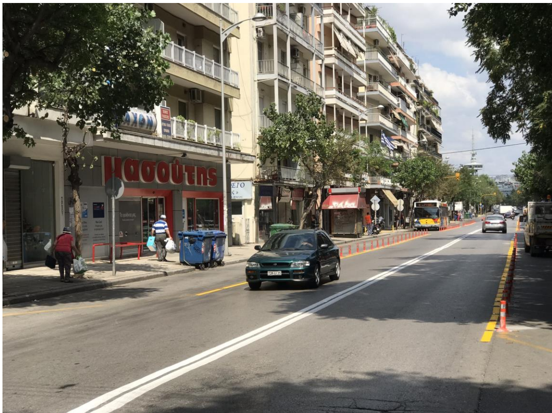
2. Επαναδιαγράμμιση της λεωφορειογραμμής και της διπλής διαχωριστικής γραμμής.
