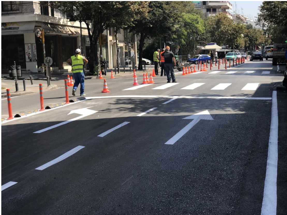
4.Οδός Γρ. Λαμπράκη με Ιπποδρομίου. Διαγράμμιση δύο λωρίδων κυκλοφορίας με "μαχαίρι" για την αριστερόστροφη κίνηση προς την οδό Ιπποδρομίου.
