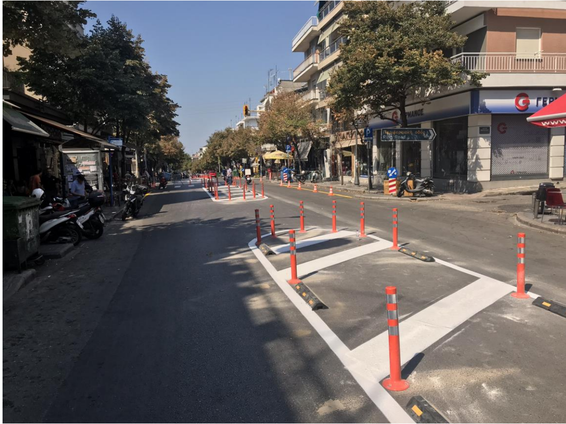
1. Οδός Γρ. Λαμπράκη (Τυρολής-Πολυγνώτου). Κατασκευή νησίδας με πλαστικά ελαστικά κολωνάκια, διαχωριστικά ελαστικά κράσπεδα και διαγράμμιση τύπου ζέβρα. Στη φωτογραφία διακοπή νησίδας στην οδό Πρωτογένους
