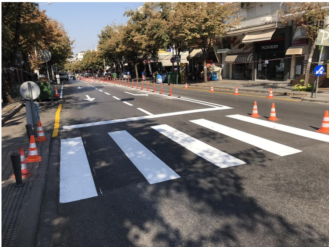
2. Οδός Γρ. Λαμπράκη με Διαγόρα. Νησίδα με ελαστικά κολωνάκια και κράσπεδα. Διαγράμμιση δύο λωρίδων κυκλοφορίας, η μια με κατασκευή "μαχαιριού" για την ανεξάρτητη αριστερόστροφη κίνηση του σηματοδότη προς την οδό Διαγόρα.
