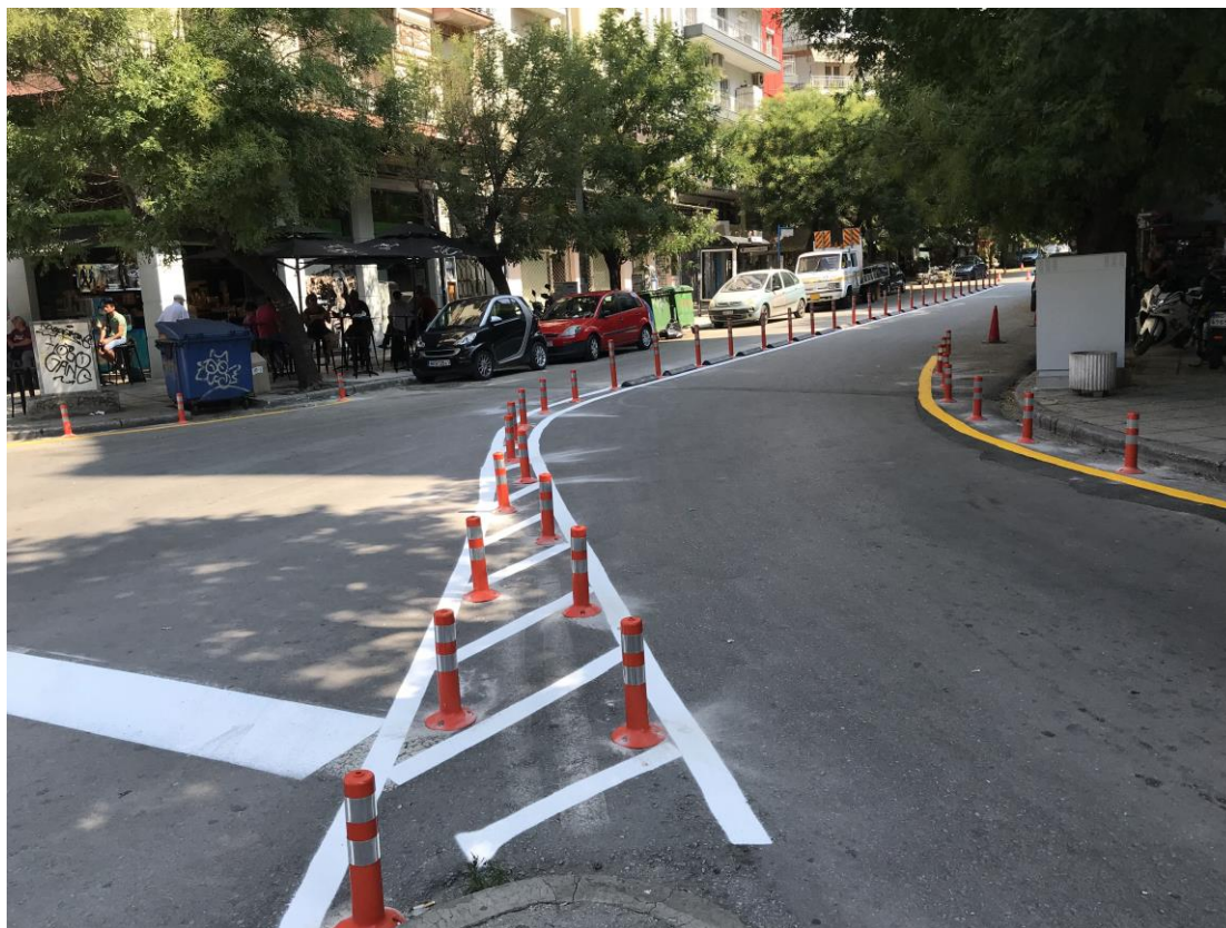
1.Οδός Αντιγονιδών με Εγνατία. Διαχωρισμός των δύο κατευθύνσεων με ελαστικά κράσπεδα και εύκαμπτους οριοδείκτες. Αποτροπή παράνομης στάθμευσης με τοποθέτηση εύκαμπτων οριοδεικτών στις γωνίες.
