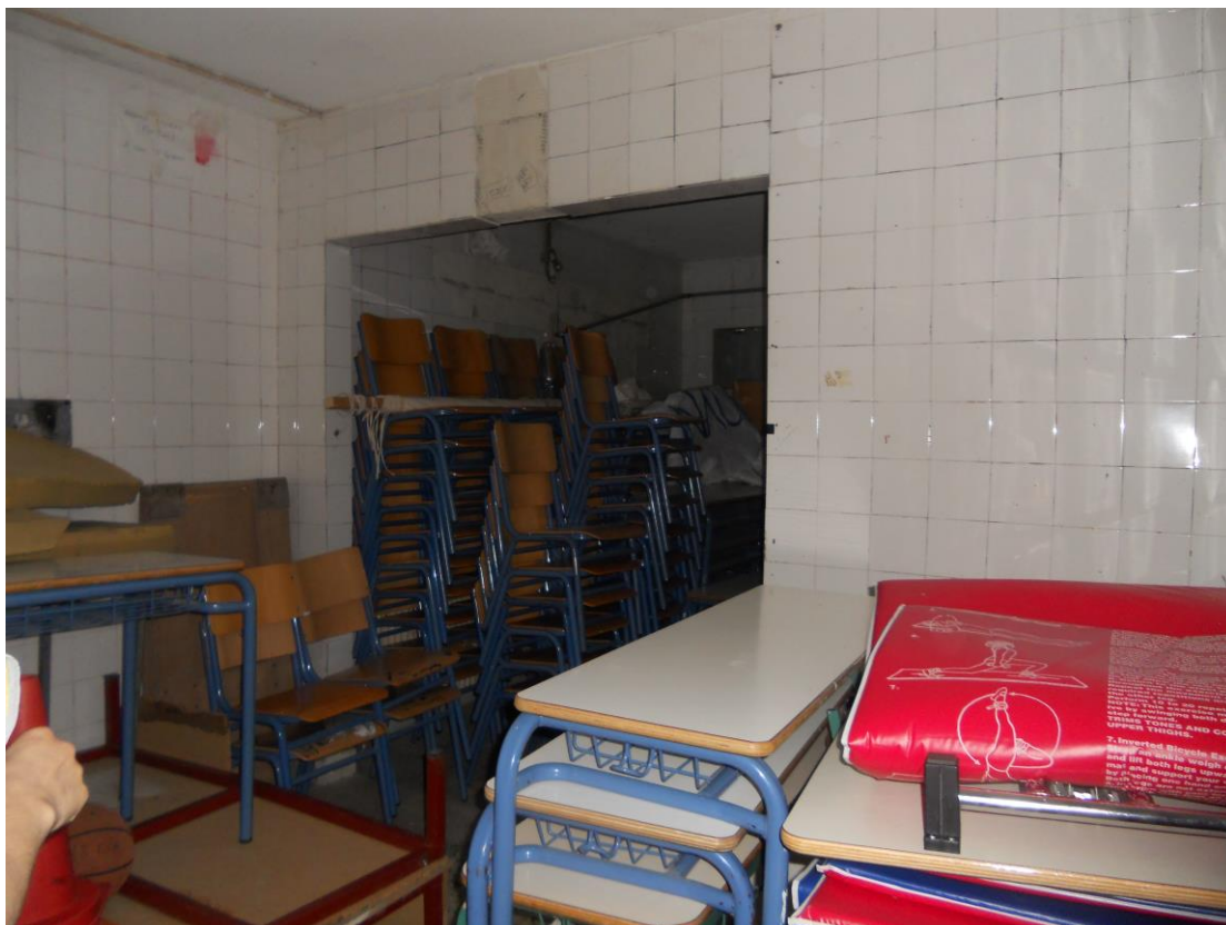
Εικόνα 22 Υφιστάμενη κατάσταση του χώρου που θα τοποθετηθεί το αντλιοστάσιο
