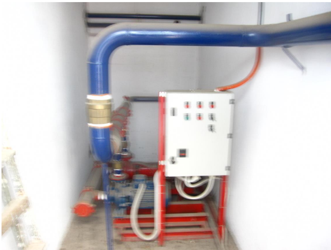
Εικόνα 14 Υφιστάμενο Πυροσβεστικό συγκρότημα
