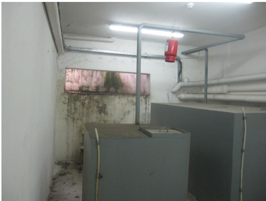
Εικόνα 17 Υφιστάμενη κατάσταση του χώρου που θα τοποθετηθεί το αντλιοστάσιο
