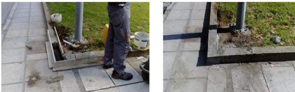
Β. Γεωργίου 1-3: Κατασκευή χαμηλού τοιχείου μπετόν γύρω από το περίπτερο
