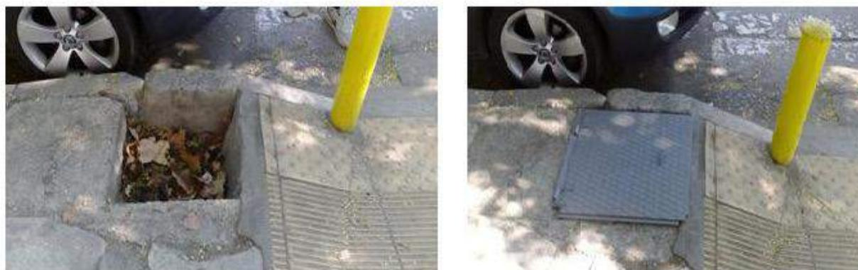
Πάρκο Αρμένικο: Αποξήλωση χαμηλών μεταλλικών κιγκλιδωμάτων και πλήρωση οπών με άοπλο σκυρόδεμα.
