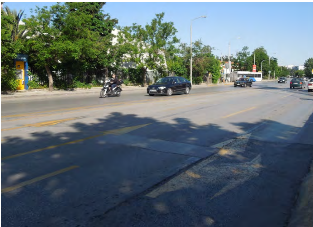
Φωτ. 2.2 Βέλη κατεύθυνσης λωρίδας κυκλοφορίας που υποδεικνύουν ευθεία κίνηση στον κόμβο Εγνατίας-3 ης Σεπτεμβρίου (προς κέντρο)
