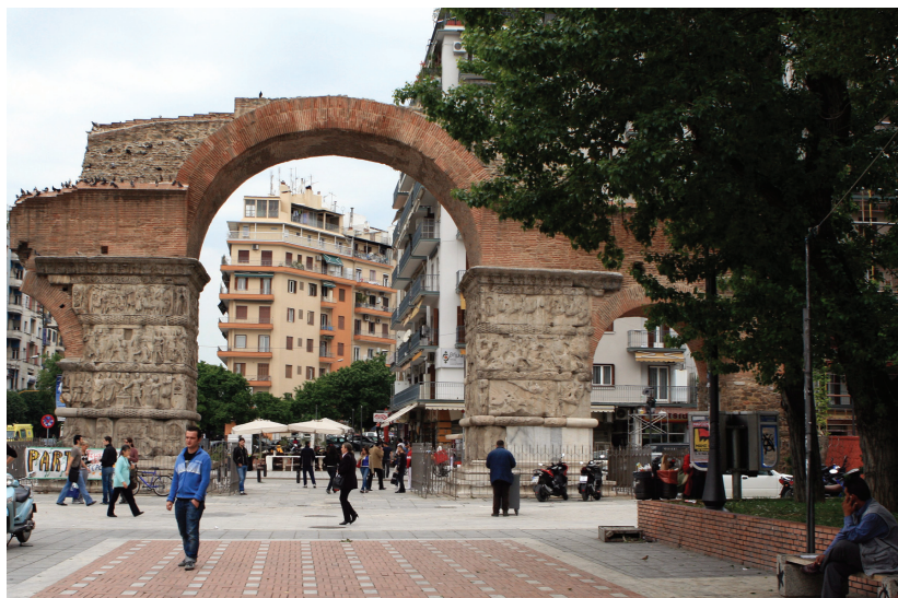
Σύγχρονη όψη της Καμάρας, μετά την ανάπλαση της περιοχής, από το Δήμο Θεσσαλονίκης. Moderne Ansicht des Triumphbogens des Galerius nach der Neugestaltung des Gebiets durch die Stadtgemeinde Thessaloniki.
